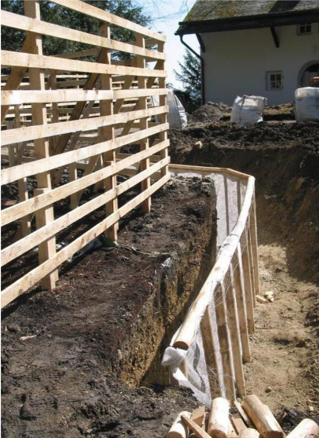
**Abbildung 2: Baumschutzzaun und Wurzelschutzzaun – fachgerechter Wurzelschnitt – vor der Hinterfüllung mit humusreichem Substrat** (Foto: LRA Starnberg)
